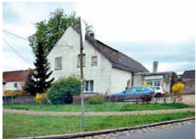
Objekt in Torgau, Ortsteil Staupitz Quelle: LfV Sachsen
